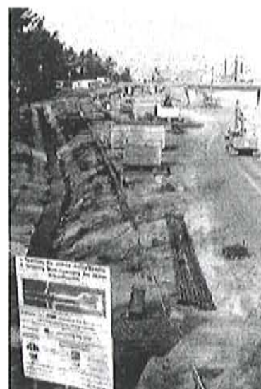
Bauarbeiten am unteren Auslaufkanal
