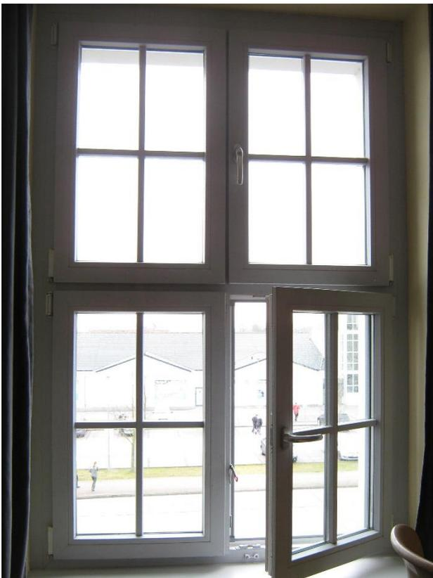
*Bild 6: Vierteiliges Dreh-/Drehklipp-Fenster im Raum 312 (Unterrichtsraum), Südost-Fassade*
