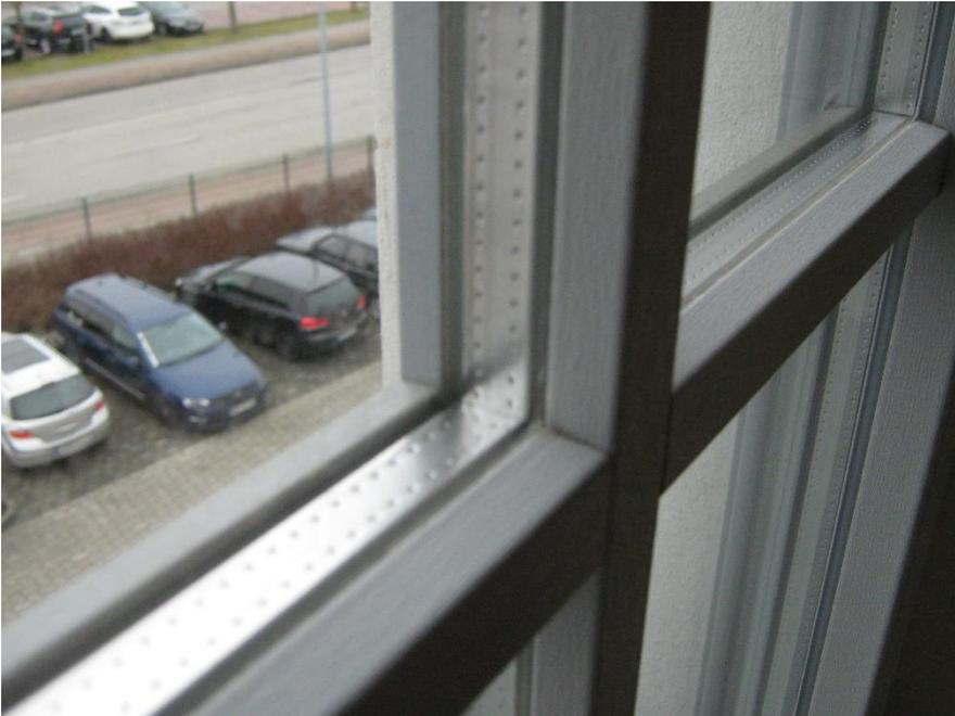
*Bild 9: Kreuzsprosse und Ansicht der 2-Scheiben-Isolierverglasung*
