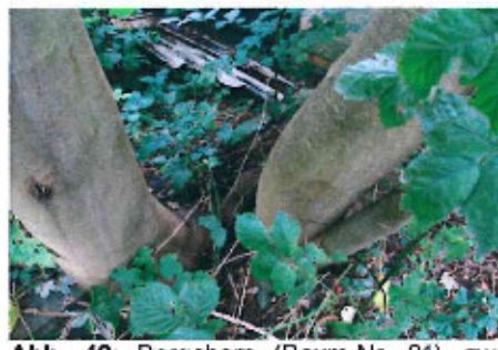
Abb. 42: Bergahorn (Baum-Nr. 21), zwei Bäume, Verlauf der Wurzeln entlang von Betonelementen (Quelle: Gutachten BAUER)
