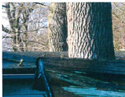
Abb. 22: Stieleiche (Baum-Nr. 9) Eingebauter Stamm (Quelle: Gutachten FRANIEL)
