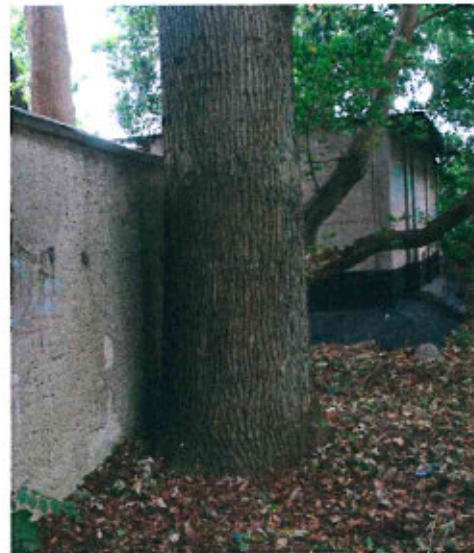
Abb. 15: Stieleiche (Baum-Nr. 3b) Standort nahe der Garagen (Quelle: Gutachten BAUER)
