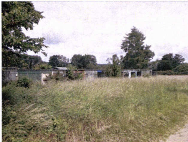
Ortsbildstörende Garagenanlage im westlichen Plangebiet.
