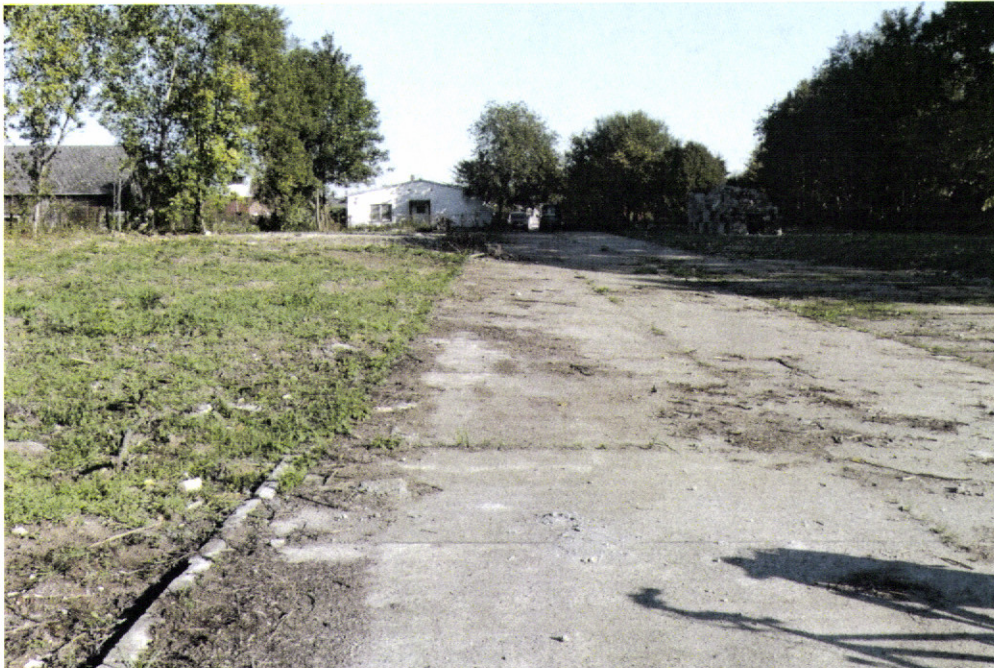
Foto: Blick nach Osten in Richtung Dorfstraße auf die zentrale Fläche aus Beton.
