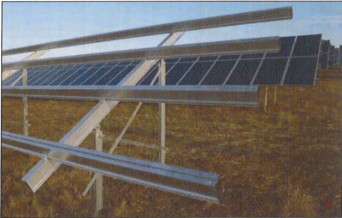
Abbildung 3: Systemdarstellung zur Aufständigung der Gestelleinheiten. Quelle: S.I.G. 2012.
