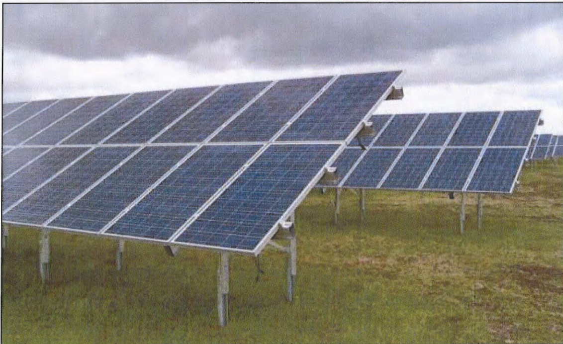
Abbildung 4: Detailansicht der zweireihigen Modultische. Quelle: S.I.G. 2012.
