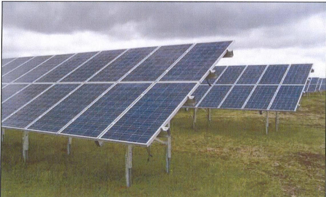
Abbildung 4: Detailansicht der zweireihigen Modultische. Quelle: S.I.G. 2012.
