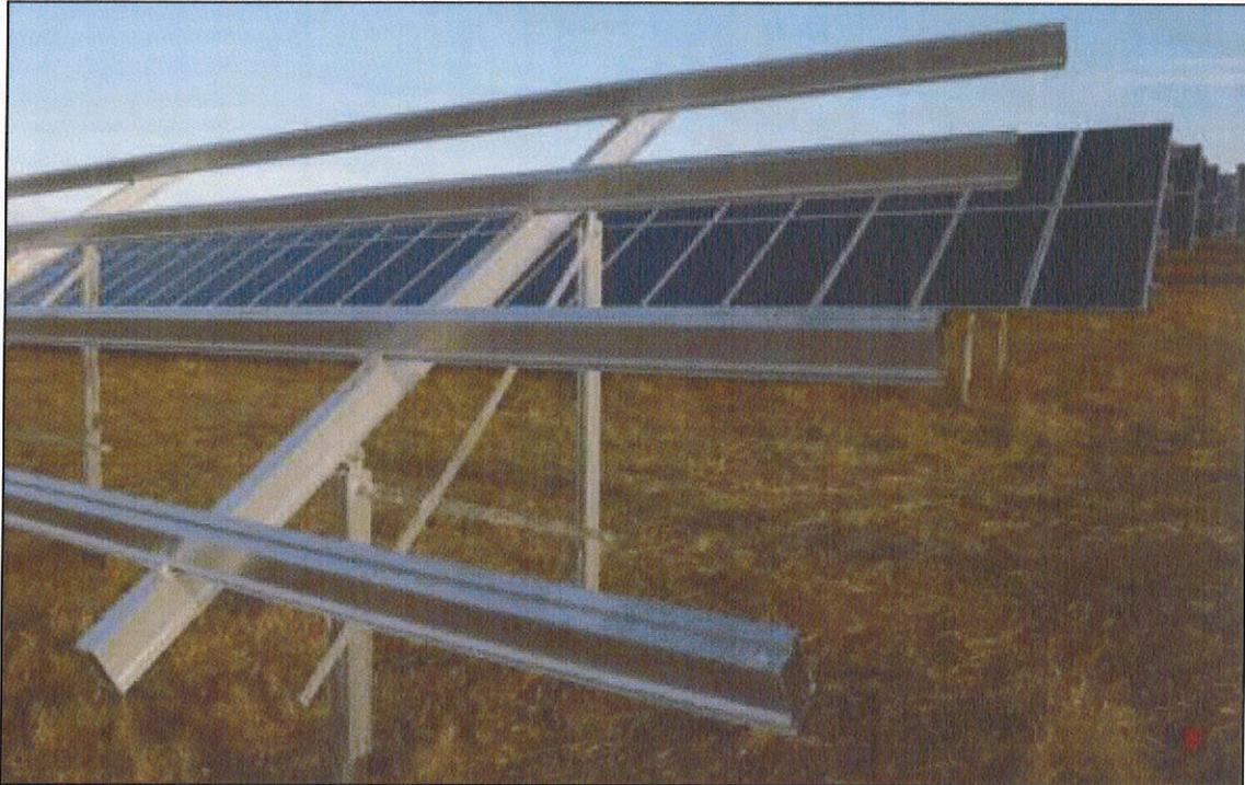
Abbildung 3: Systemdarstellung zur Aufständigung der Gestelleinheiten. Quelle: S.I.G. 2012.
