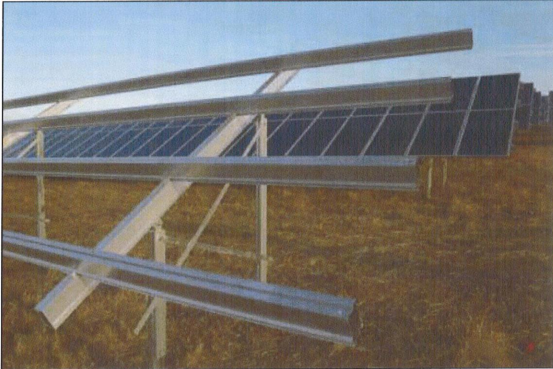
Abbildung 3: Systemdarstellung zur Aufständerung der Gestelleinheiten. Quelle: S.I.G. 2012.
