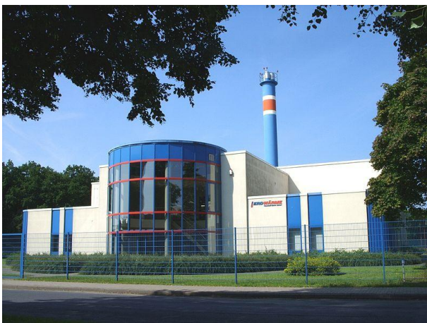
picture 1 - heating plant Neustadt-Glewe ( http://de.wikipedia.org/wiki/Geothermiekraftwerk_Neustadt-Glewe )
