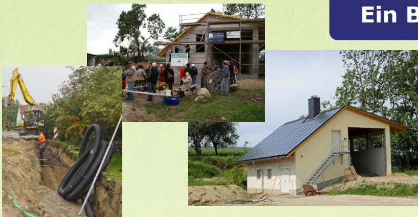
Einwohner von Stellshagen haben die Vorzüge der Holzhackschnitzelheizung durch das Bio- und Gesundheitshotel „Gutshaus Stellshagen“ direkt erfahren und die Straßenbauarbeiten im Jahr 2010 zur Verlegung eines Wärmenetzes genutzt. 14 Haushalte sind angeschlossen, über Erweiterung wird nachgedacht.
