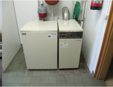
Abb.38: Kessel+ Warmwasserspeicher
