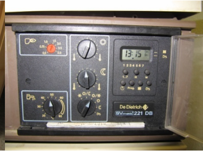
Abb. 39: Heizungsregler
