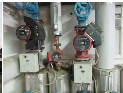
Abb. 8: Heizkreisverteiler
