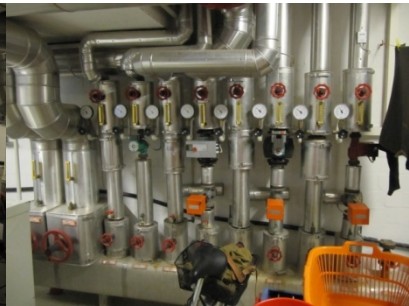
Abb.18: Heizkreisverteiler
