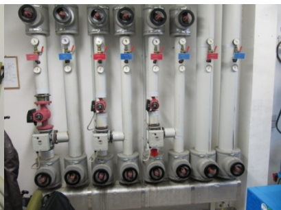
Abb. 21: Heizkreisverteiler
