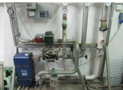
Abb. 9: Fernwärmestation
