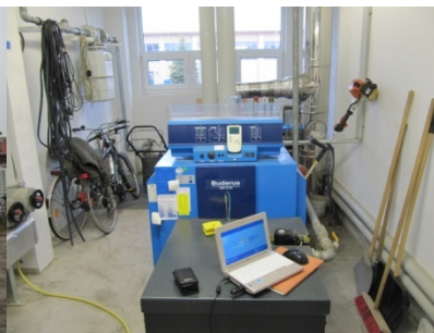
Abb. 20: Heizkessel mit Regelung
