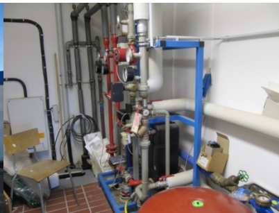
Abb. 32: Fernwärmestation
