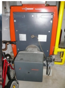
Abb. 11: Gasheizkessel
