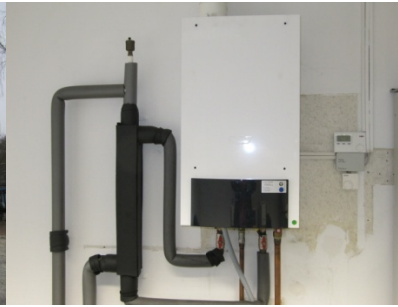
Abb. 23: Gasbrennwertgerät Wolf
