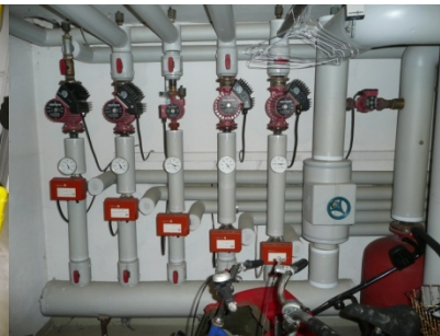
Abb. 12: Heizkreisverteiler
