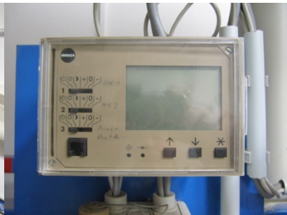
Abb.33: defekter Fernwärmeregler
