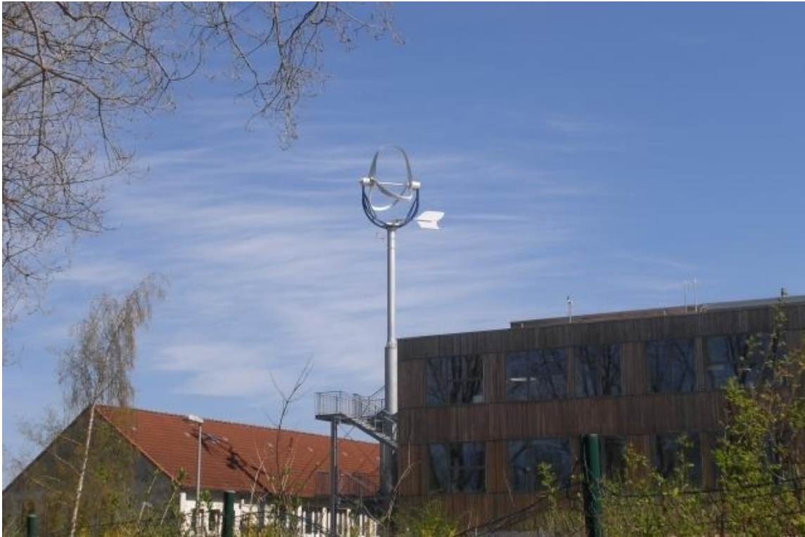
Abb. 4: Klein-WEA von Dela-Rotor an einer Plusenergieschule in Rostock (M-V) 5
